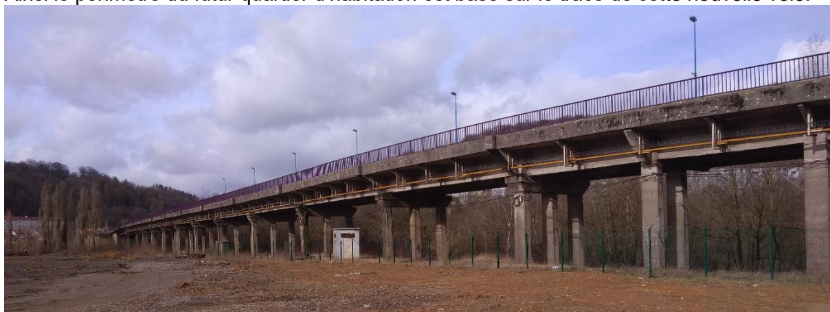
Vue du viaduc depuis la STUL - Source : l'AdT
