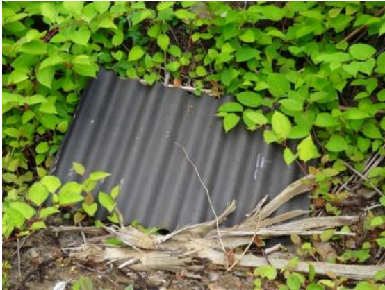
Plaque P5 sur le talus Nord de l'ancienne voie
