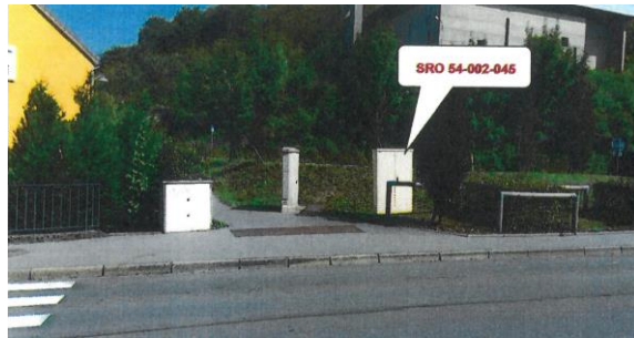
Avenue de la Concorde/Croix St Jean
